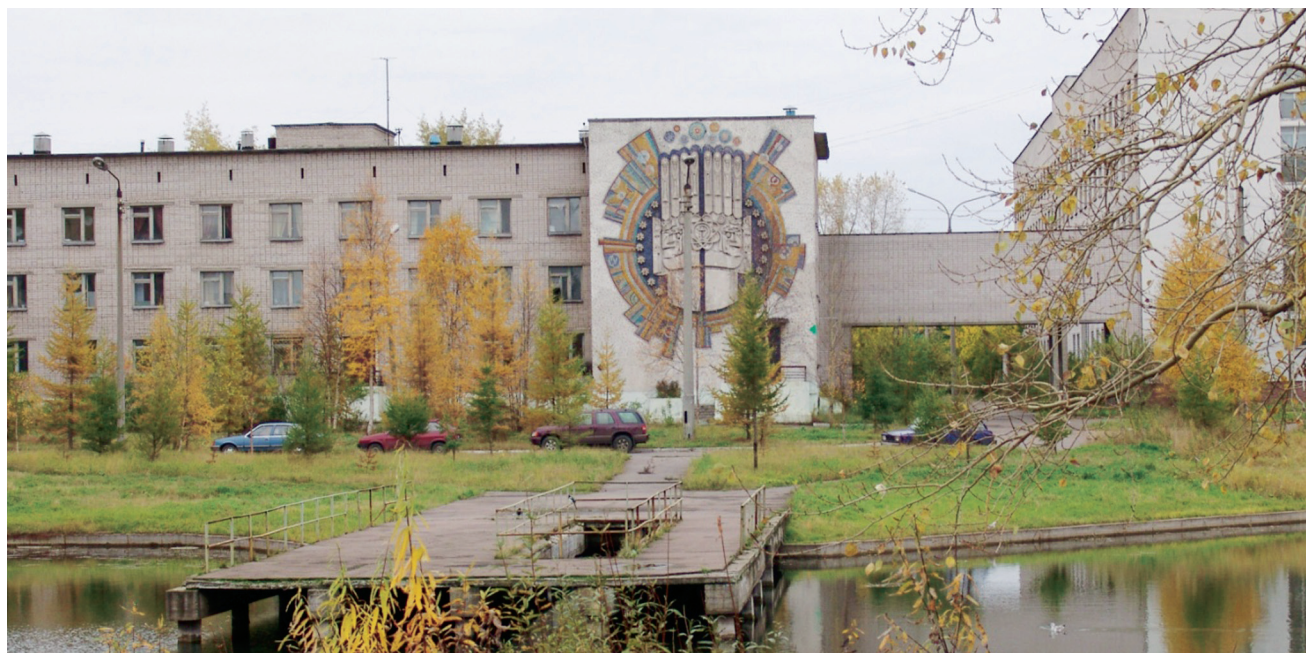
Рис. 5. 3-х этажный корпус:
