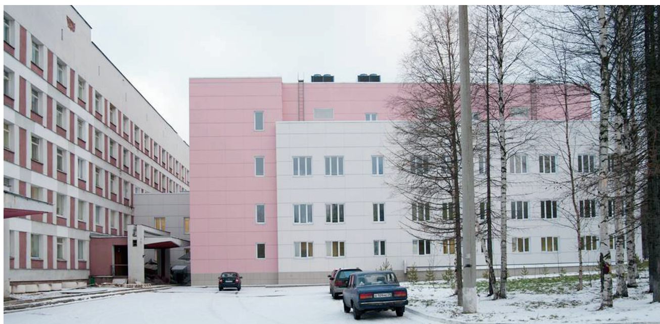
Рис. 6. Новый операционный корпус
